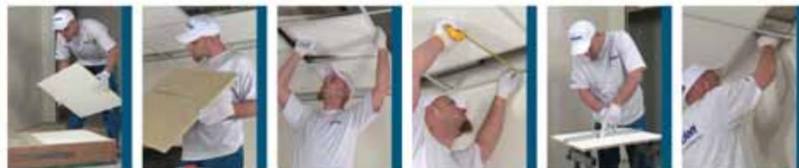
При монтаже панелей будьте внимательны и соблюдайте необходимые нормы безопасности. Монтаж потолочных панелей рекомендуется проводить в белых перчатках, чтобы не оставлять следы на белых поверхностях панелей.
